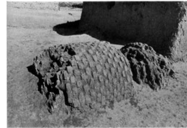
6. Fallen column (No. 3).
