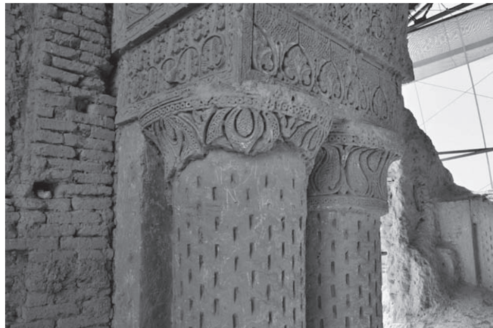
FIG. 17. – Chapiteaux de la colonne 9 de la mosquée Hâji-Piyâdah/Noh-Gonbadân. Vue vers le sud. La partie cassée du bas de chapiteau à gauche montre que l'ornement en creux du fût de sa colonne se prolonge jusqu'en dessous de ce chapiteau, ce qui pourrait suggérer que le chapiteau a été ajouté a posteriori (© Adle).
