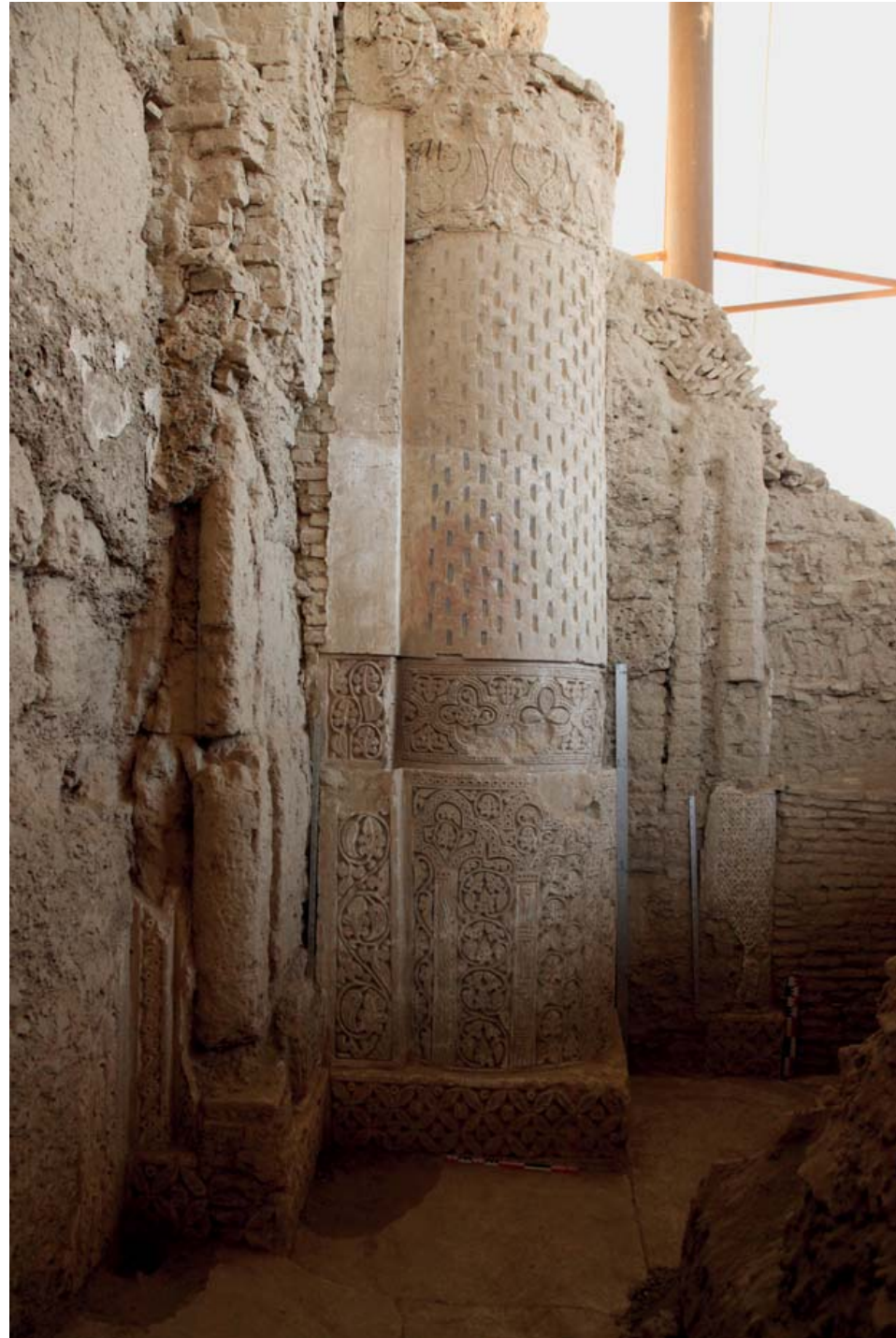
FIG. 13. – Mosquée Hâji-Piyâdah/Noh-Gonbadân. Coin ouest, colonne 16 : raccord du mur nord-ouest (en face) avec le mur qiblique (sud-ouest) à gauche. Vue vers le nord-ouest. Comme sur la façade principale au nord-est, la construction était ouverte aussi vers le nord-ouest grâce à trois arcades. Sur l'image, la baie d'en face, à droite de la colonnette ornée de fleurs de lys, a été obstruée ultérieurement avec des briques cuites (© Adle).
