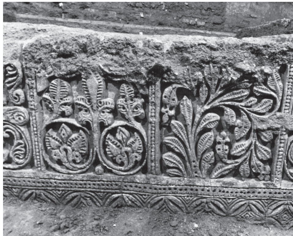
FIG. 26. – Ispahan. Mosquée Jom'eh. Décoration en plâtre sculpté datable de l'année 156/772-73 du mur qiblique attribué à la première phase de la construction de l'édifice (Secteur 205, image ICHHTO/ADAMJI).
