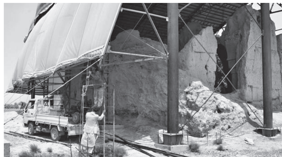
FIG. 22. – Mosquée Hâji-Piyâdah/Noh-Gonbadân. Vue rapprochée des vestiges de la pente des marches du « minaret à escalier » ( ma'dhaneh ) qui menaient sur le toit de la mosquée d'où l'appel aux prières était lancé par un muezzin (© Adle).
