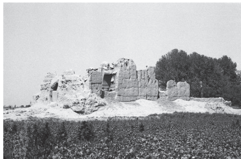
FIG. 21. – Vue des façades sud-est (à droite) et sud-ouest (côté mihrab à gauche) de la mosquée Hâji-Piyâdah prise par M me Deborah Klimburg-Salter en 1971. La pente des vestiges des marches du « minaret à escalier » menant sur le toit de la mosquée est visible au centre gauche de l'image. Elle se distingue autour de la ligne de rencontre des deux façades de l'édifice et marque son angle sud (voir l'image suivante). On voit aussi, face aux arbres, à droite de l'image, qu'une petite partie du mur SE de la cour de la mosquée était encore debout en 1971 et qu'elle ne s'était pas encore écroulée (© Klimburg-Salter 1971).
