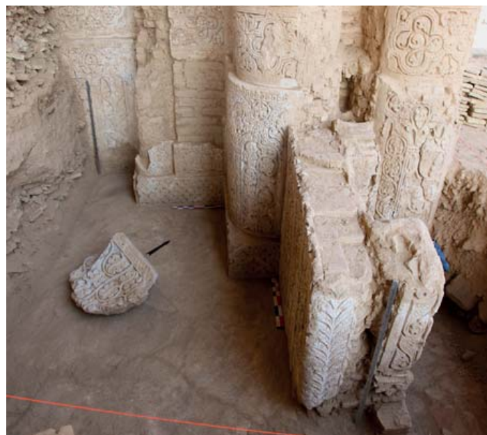
FIG. 12. – L'encoignure nord de la mosquée Hâji-Piyâdah/Noh-Gonbadân montrant les deux colonnes engagées 4 et leur raccord avec le mur paravent de la façade principale (nord-est). Un gros morceau du plâtre sculpté provenant d'une coupole effondrée de la mosquée est replacé là où elle a été trouvée un peu plus haut parmi les décombres. Le creusement vertical dans la murette en bas à droite pourrait correspondre à l'empreinte laissée par le châssis d'un portillon disparu. Vue vers le nord-ouest (© Adle).
